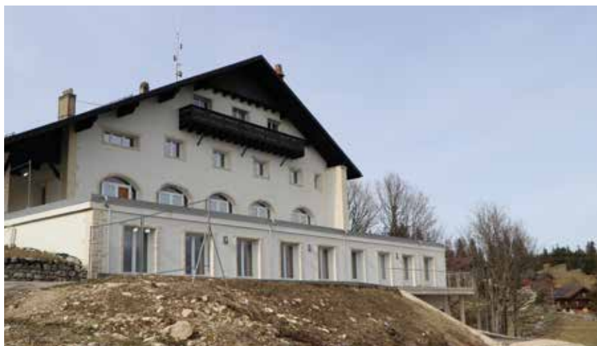
Cela fait plus de cinq ans que les travaux de rénovation de l'hôtel de Tête-de-Ran ont été arrêtés (photo pif).
